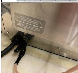
2. Collegare la terra dal tester portatile al punto di collegamento equipotenziale sul forno.
